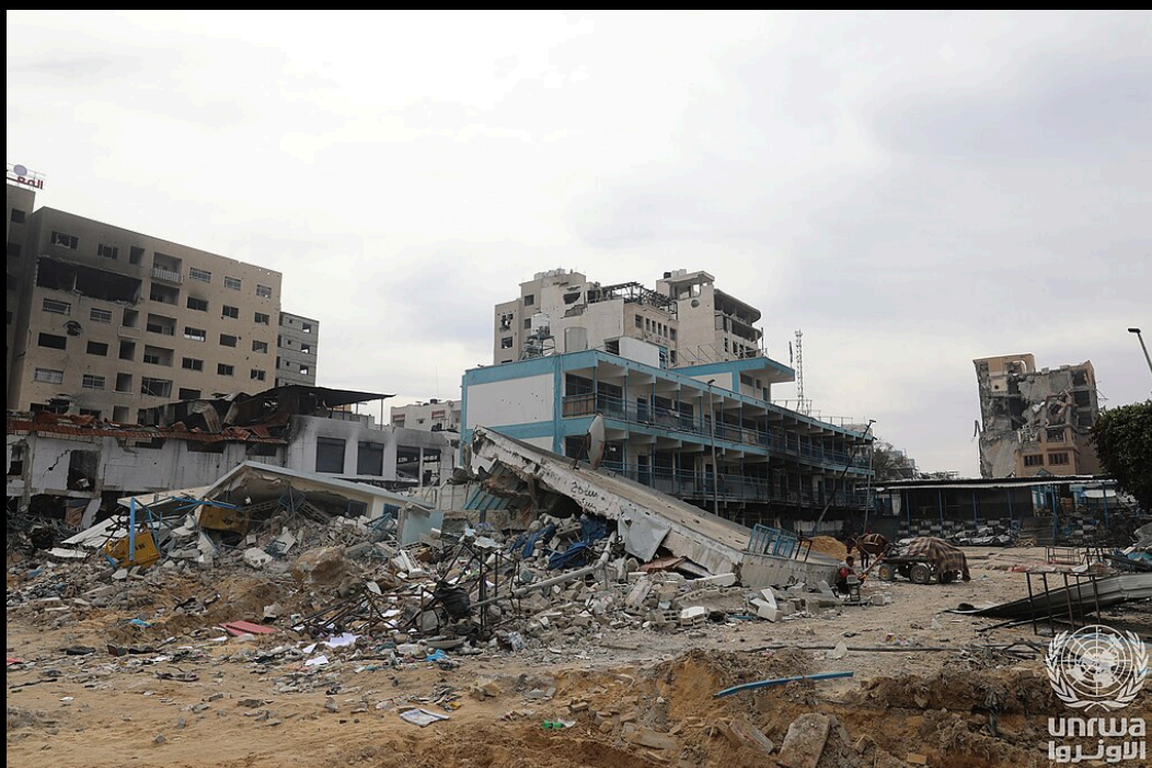
Destrucció de l'escola de nins de Zaitoun de l'UNRWA (ONU), Franja de Gaza
